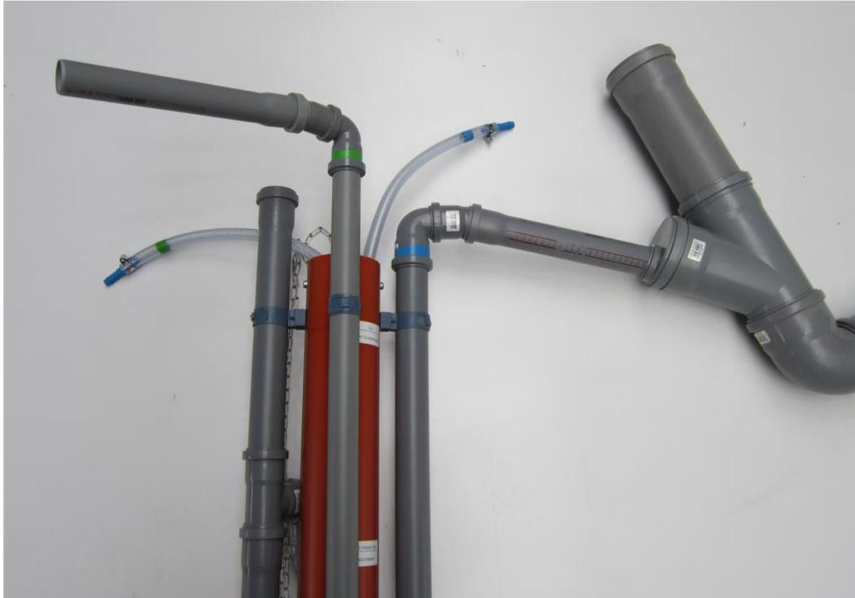
Luftschläuche vom Rüstsatz mit der Steuerungseinheit verbinden und mit Schlauchschellen sichern.
